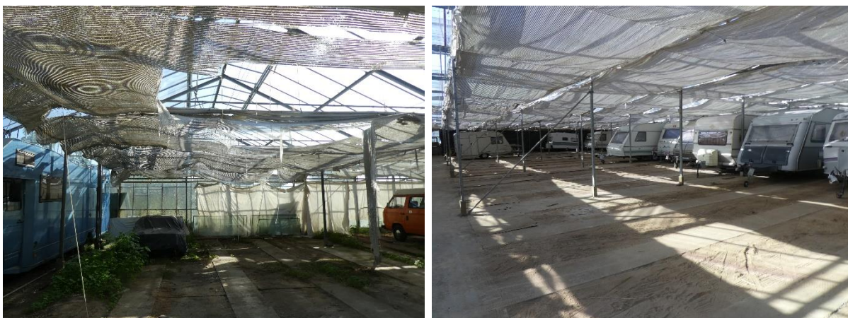
Afbeelding 3 t/m 8: Bestaande te slopen bebouwing. Bron: BNL advies. Datum: 10-08-2023
